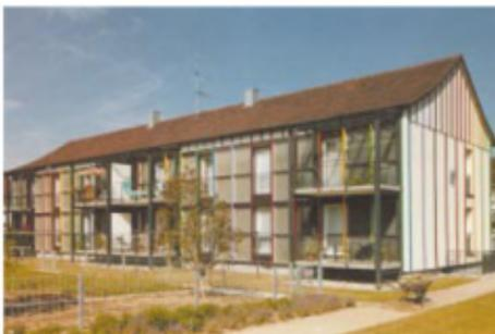
*Restauración de un edificio de departamentos de los años 50 en Freiburg, Alemania. 120 m<sup>2</sup> de TWD fueron aplicados en muros con el sistema de marcos y elementos de sombra integrados. Las placas de TWD utilizadas tienen un espesor de 10 cm y están hechas de celdas de policarbonato.*
