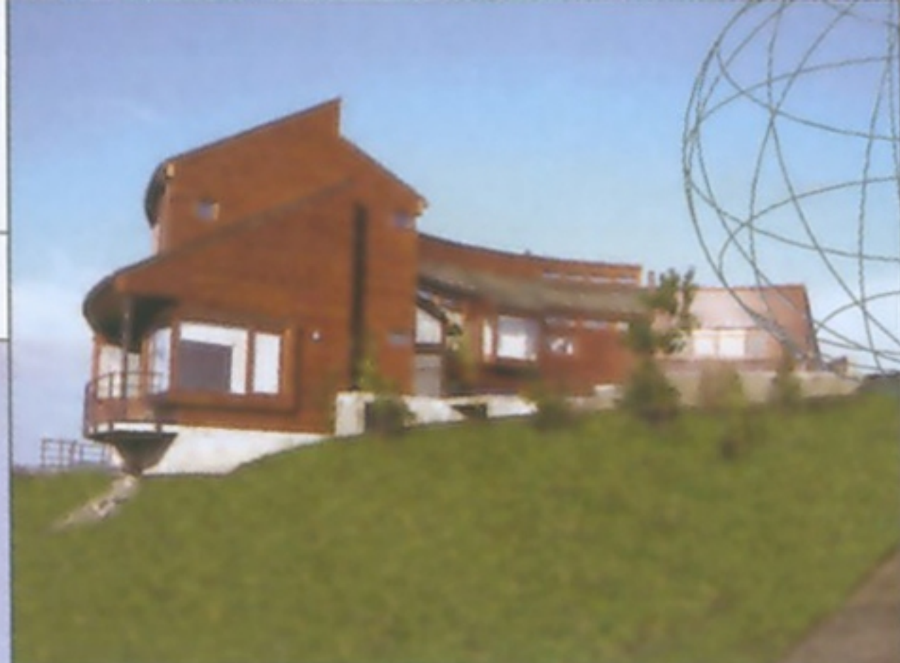
El sector noreste exhibe los detalles constructivos que definen la arquitectura buscada
