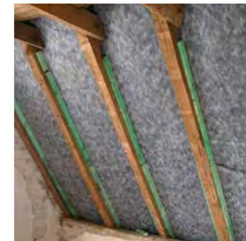
Fertige, nachträglich von innen eingebaute Unterspannung.
