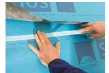
TESCON VANA Zur Verklebung der Bahnenüberlappungen
