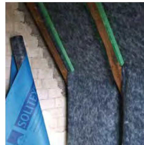
Seitlich mit Lattung fixieren. Alternativ: 3 mm Hartfaser- oder Multiplex-Streifen verwenden. Entwässerung über den Dremmel in den Traufbereich sicherstellen.
