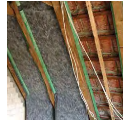
SOLITEX gefachweise längs oder quer einbauen. Auf wasserführende Überlappung achten.
