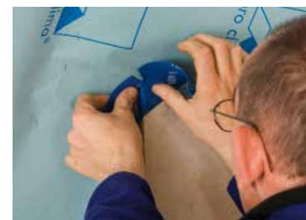
Ecken mit kurzen Stücken TESCON No.1 / TESCON VANA abdichten. Das Klebeband mittig bis zur Hälfte einschneiden. So kann es einfach angeformt werden.
