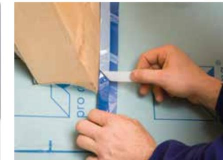
Im zweiten Schritt einfach die restlichen Trennfolienstreifen entfernen und die Verbindung komplett herstellen.
