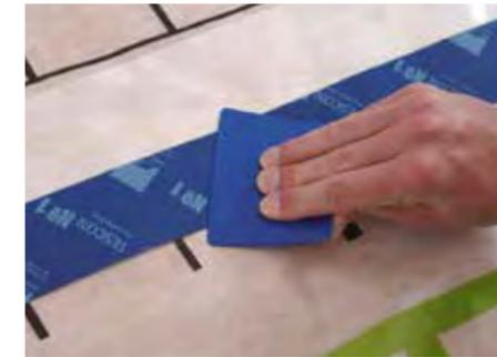
Das Band mittig ansetzen und z. B. mit dem pro clima PRESSFIX fest anreiben. Als Orientierungshilfe dient die gestrichelte Markierung, die 3 cm vom Rand auf die Bahn aufgedruckt ist.
