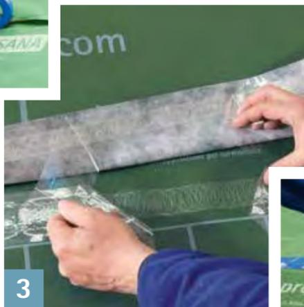
Verklebung der Bahnenüberlappungen erfolgt bei der pro clima INTESANA connect mit den zwei integrierten Selbstklebezonen. Die Bahnenüberlappungen der pro clima INTESANA sowie Kopfstöße werden mit dem doppelseitigen Klebeband pro clima DUPLEX oder dem einseitigen TESCON No.1 / TESCON VANA verklebt. Klebebänder fest anreiben, z. B. mit der Anreihilfe pro clima PRESSFIX.
