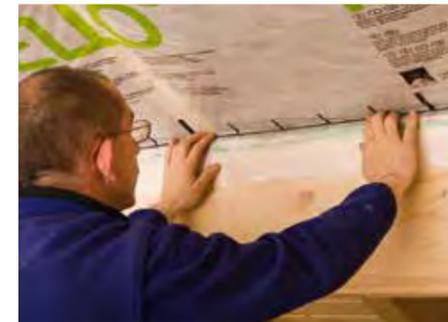
vergrößern. Eine Alternative ist ORCON LINE. Anschließend die Dampfbremse mit einer Dehnschleife (wenn möglich) in das Kleberbett legen. Kleber nicht ganz flach drücken.
