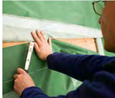
Bewitterbare Hochleistungs-Dampfbremse für Aufdachdämmungen mit feuchtevariablem  $s_d$ -Wert. Einsatz auf Schalungen unter Aufsparrendämmungen bei allen außen diffusionsoffenen Konstruktionen. Darüber hinaus bietet INTESANA ein hohes Bauschadensfreiheitspotenzial bei bauphysikalisch anspruchsvollen Konstruktionen wie diffusionsdichten Flach-/Steildächern und Gründächern. Auch bei extremen Außenklimabedingungen wie im Hochgebirge.
