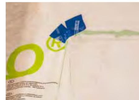
flach drücken. Alternativ ORCON LINE verwenden. Ecken mit kurzen Stücken TESCON No.1 oder TESCON VANA abdichten. Das Klebeband mittig bis zur Hälfte einschneiden. So kann es einfach angeformt werden.
