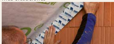
Efectuar una conexión hermética con el muro
