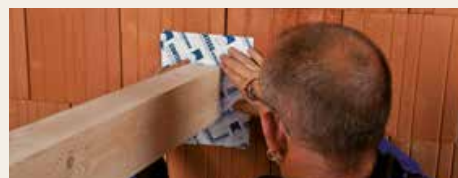
Atravesar una viga por una pared
